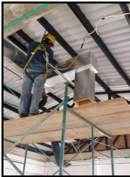
Instalación aire acondicionado subestación la playita.
