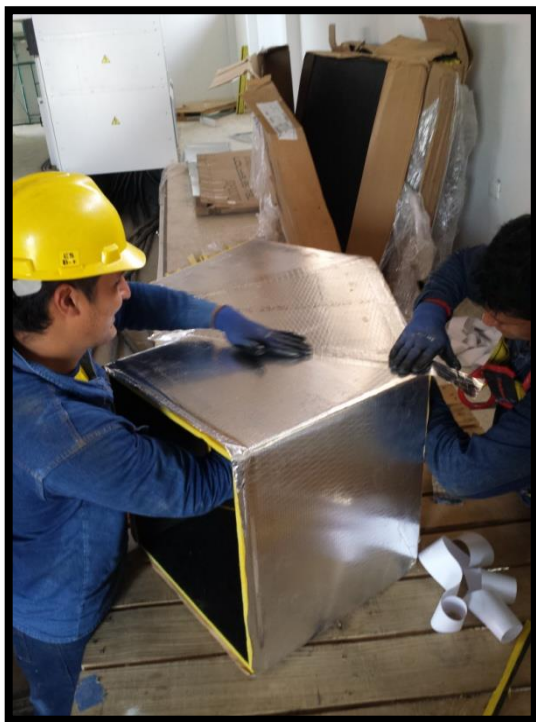
Instalación aire acondicionado subestación la playita.
