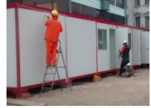
CAMPAENTO DE OBRA
