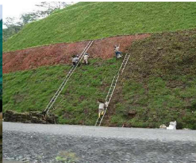
REVEGETALIZACIÓN DE TALUDES
