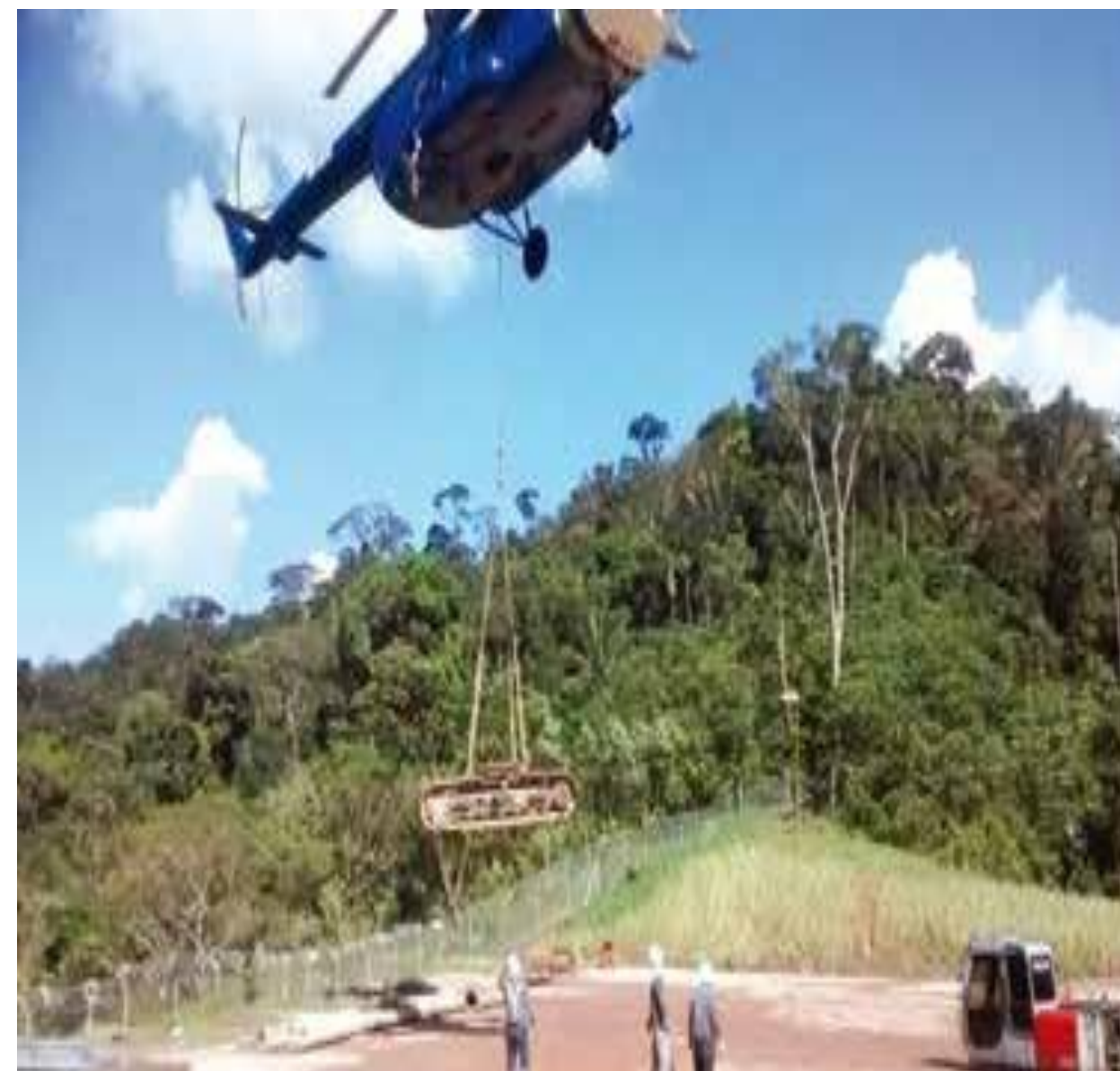
Desarme de maquinaria para helicoportaje y transporte
