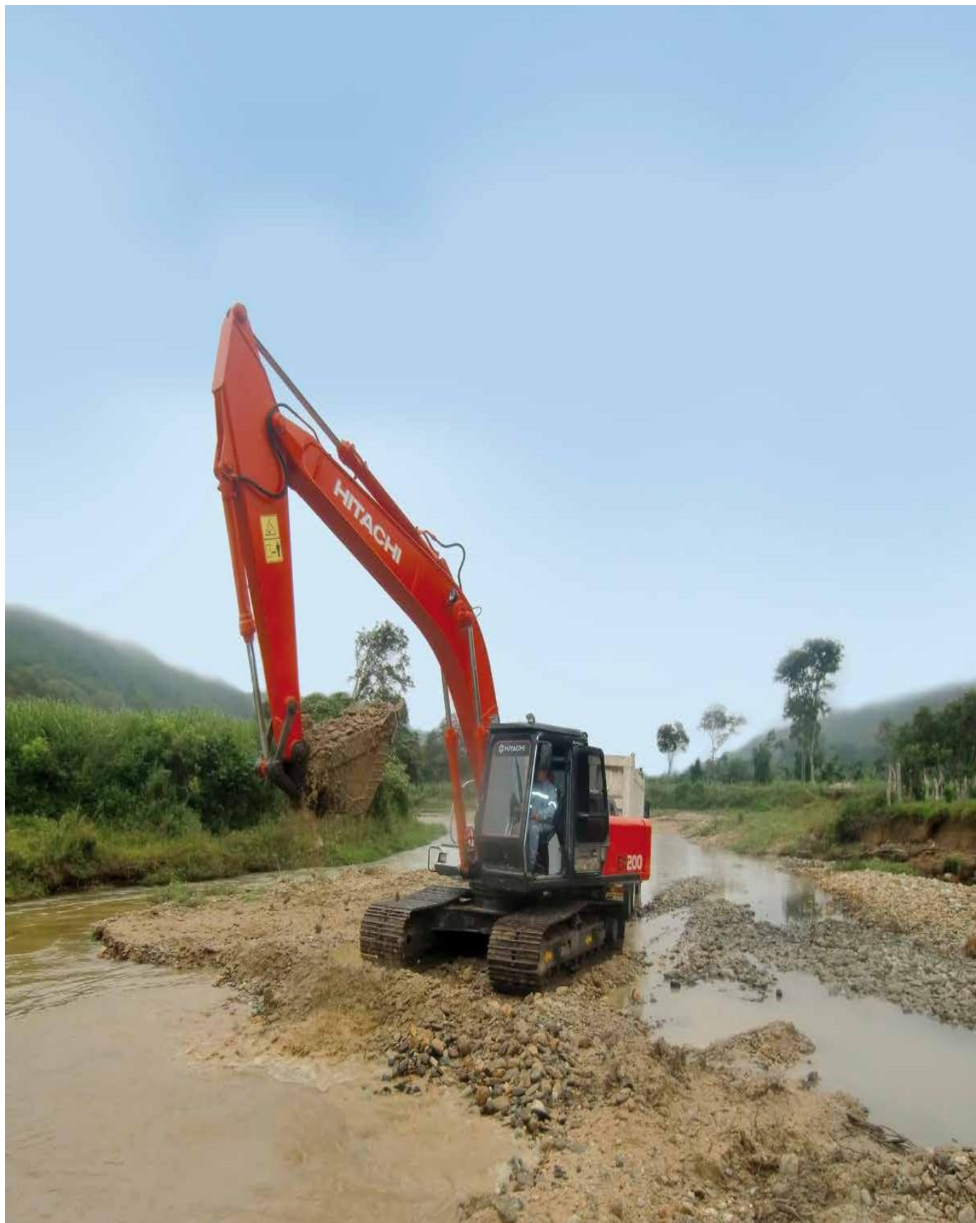
Retroexcavadora sobre oruga Hitachi tipo 200
