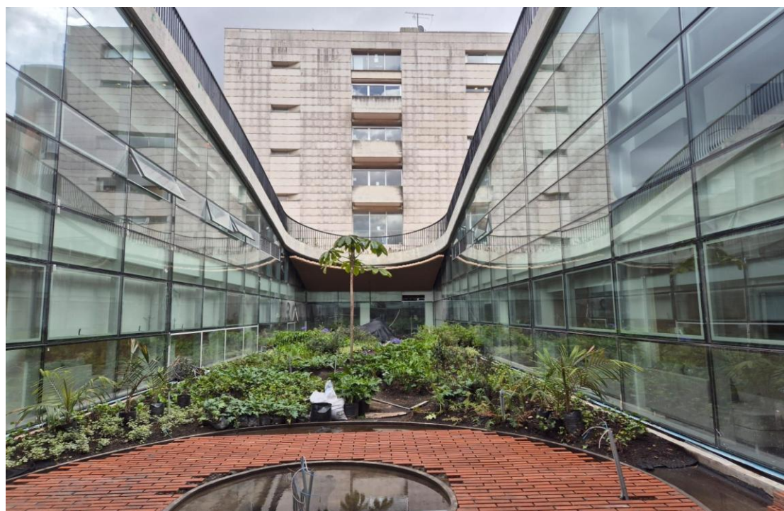
FUNDACIÓN SANTA FE GRADEN BUILDING – BOGOTÁ
