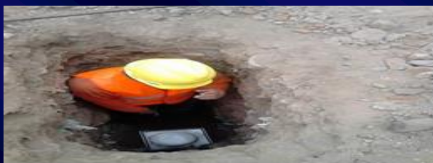
ENSAYO DEL CONO Y ARENA, DENSIDAD IN SITU.
