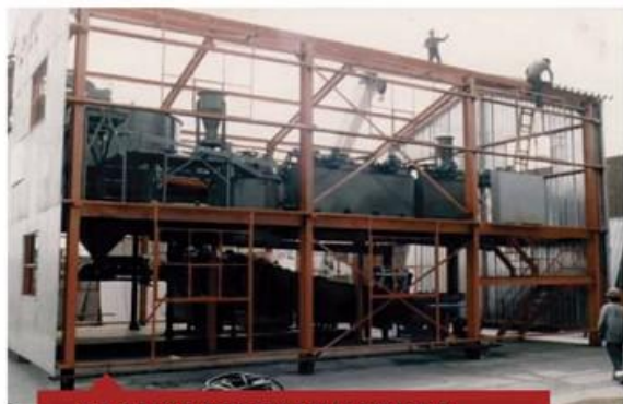
PLANTA CONCENTRADORA DESMONTABLE
