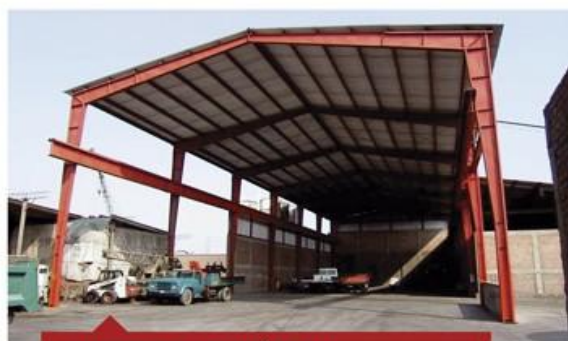
EDIFICIO METÁLICO (en construcción)
