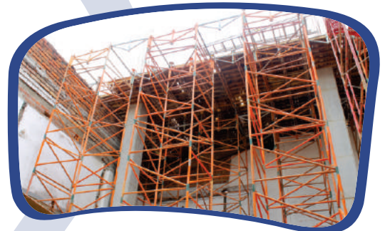
Andamio de Carga
