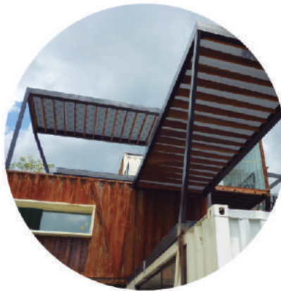
Contenedores Estructura Metálica
