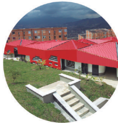
Jardín Infantil La Huerta Estructura Metálica
