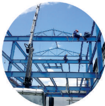
Metalmecánica Fabricación y Montaje de Estructuras Metálicas, Corte, Doble y Soldadura
