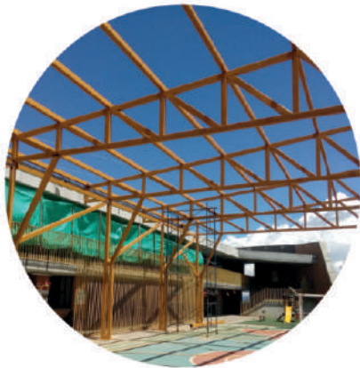
IE Chaparral San Vicente Estructura Cubierta
