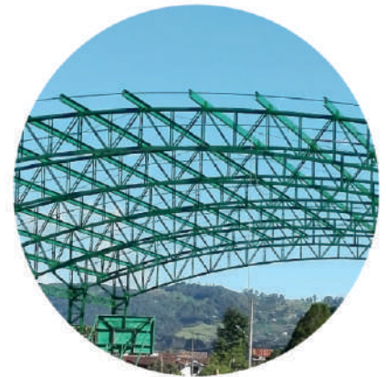
IE La Paz La Ceja Estructura Cubierta
