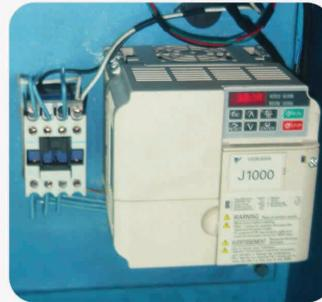
Permite que el motor trabaje de manera eficaz, sin esforzarlo, además optimiza el consumo de energía, generando ahorro de la misma
