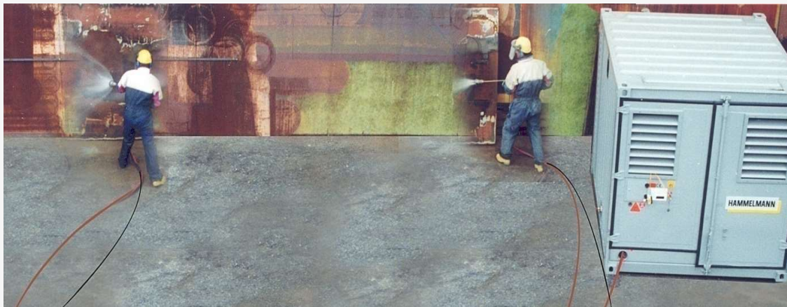
HIDROJATEAMENTO COM UMA BOMBA E DOIS BICOS
