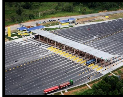
✓ Concessões Rodoviárias Concesiones Rodoviárias
