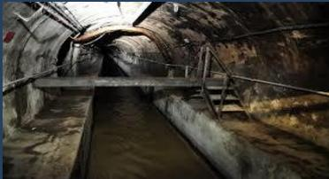
Existen tres tipos genéricos de alcantarillados: Alcantarillados pluviales (para aguas lluvias), alcantarillados sanitarios (para aguas residuales) y alcantarillados combinados (donde se mezclan aguas lluvias y aguas residuales). Los tratamientos de dichas redes son personalizados y se estudiará cada caso de forma particular.
