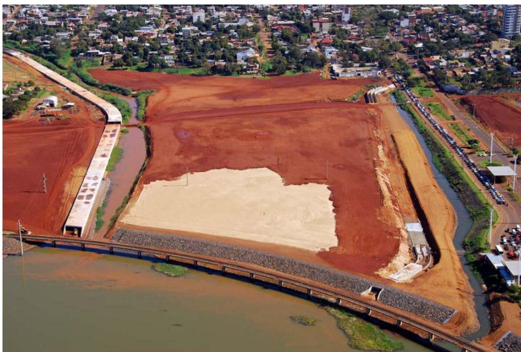
Entubamiento de Arroyos Vicario y Mitre Posadas - Misiones
