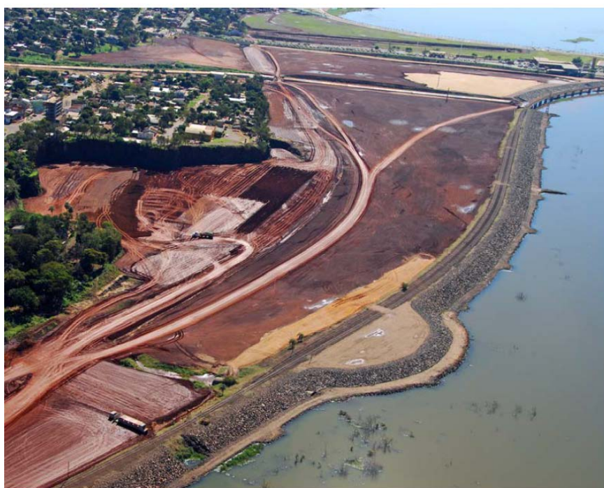
Protección Costera del Río Paraná - Posadas - Misiones
