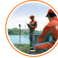
Inspección & Rehabilitación de Tuberías de Agua
