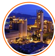
Inspección en Origen
