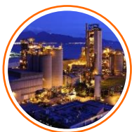
Inspección en Origen
