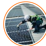
Inspecciones: civil, mecánica, eléctrica
