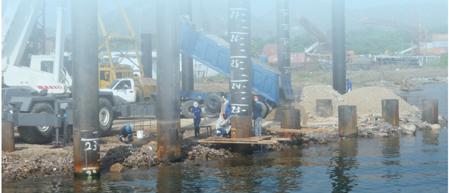
■ CONSTRUCCIÓN DEL PILOTAJE PARA UN MUELLE DE CONCRETO ARMADO SOBRE PILOTES EN GUANTA, VENEZUELA.
