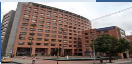
EDIFICIO PLAZA 67 – REVISIÓN SPCI
