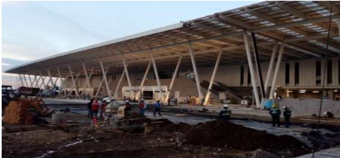
ETRAM CUATRO CAMINOS PARADERO SUR Cliente: SWECOMEX (GRUPO CARSO)
