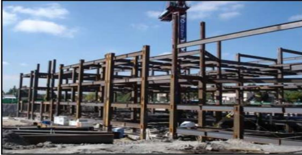
CENTRO COMERCIAL LINDAVISTA MEXICO, D.F. Vol. 9,000 TONS AGO 2005 A MAYO 2006 Montaje Estructura Metálica Instalación Lámina Losacero
