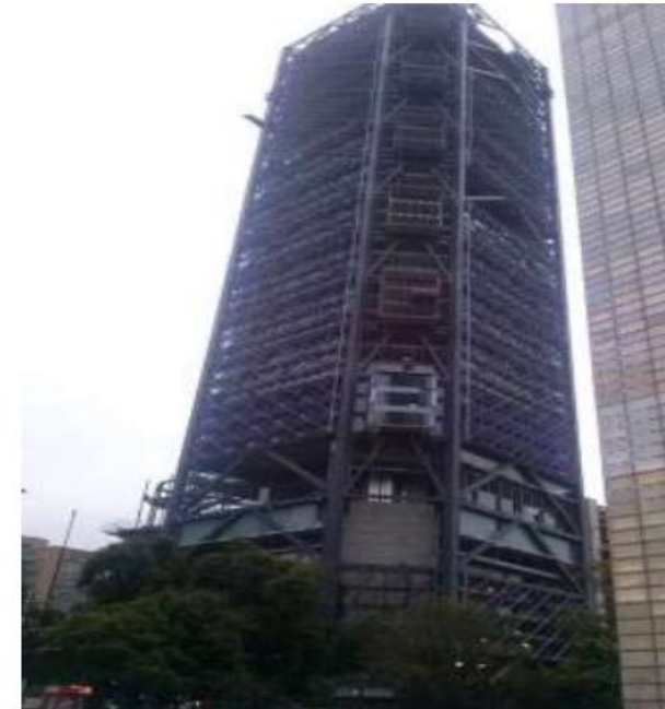
TORRE BBVA BANCOMER Cliente: COREY ESTRUCTURAS MEXICO, D.F. 21,000 TONS Preensamble de Megamarcos Montaje Estructura Metálica
