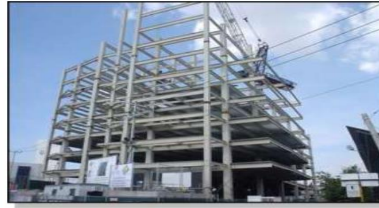
EDIFICIO ESTACIONAMIENTO MERCADO DE ABASTOS GUADALAJARA, JAL. Vol. 2,000 TONS MAR-JUL 2003 Montaje Estructura Metálica Instalación Lámina Losacero
