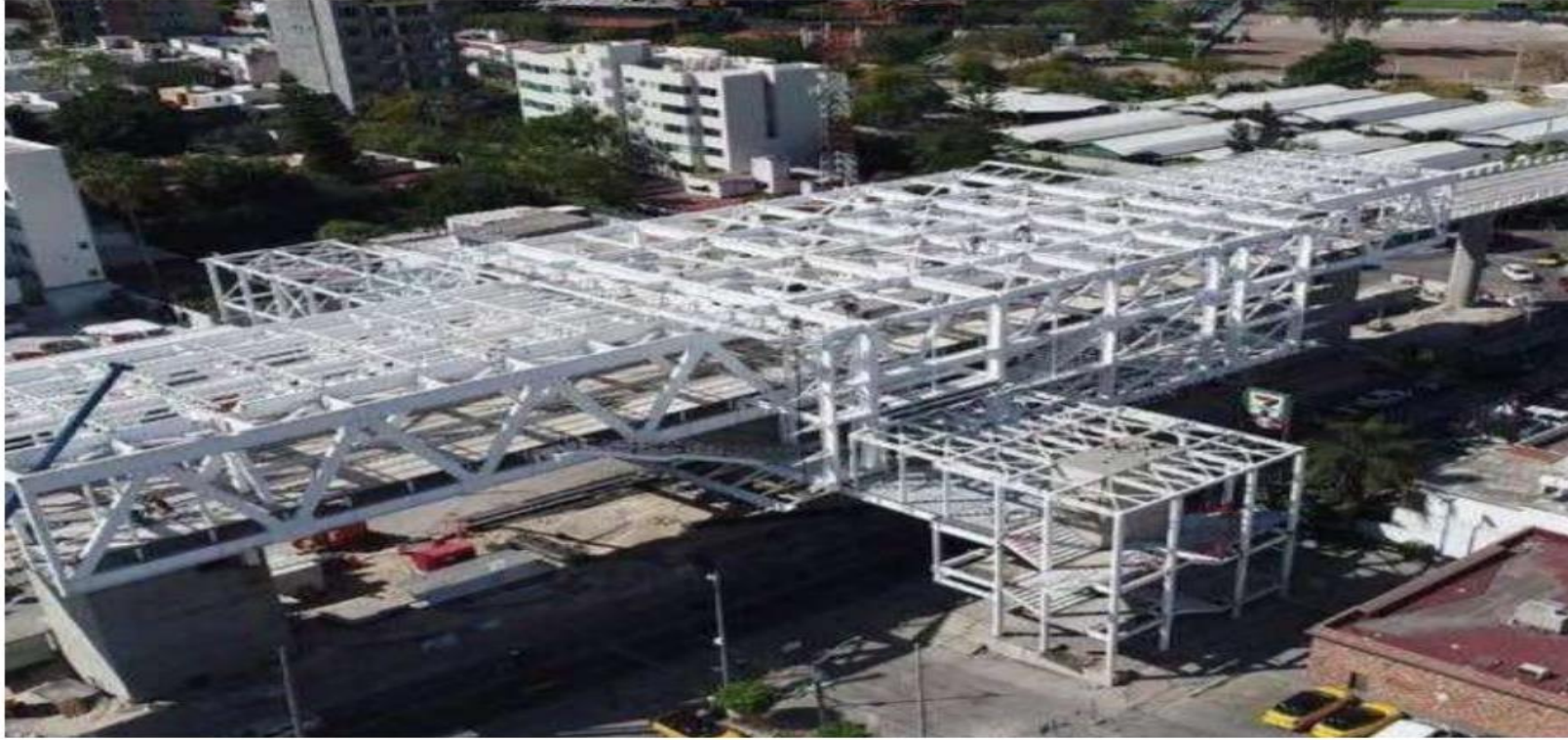
ESTACION CIRCUNVALACION LINEA 3 TREN LIGERO GUADALAJARA.
