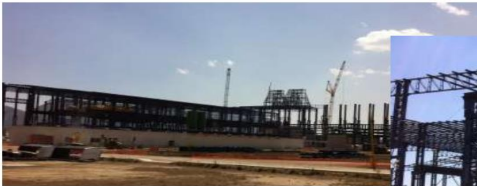
ACERIA GERDAU CORSA CD. SAHAGUN, HGO. Montaje Estructura Metálica
