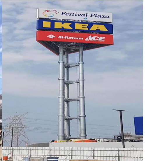
匈牙利广告塔项目 200 吨 2019 年 7 月完成 主要规格: 1600*30*8.7M. Hungarian advertising tower project. 200t. Completed in July 2019. Main specification: 1600 * 30 * 8.7m.
