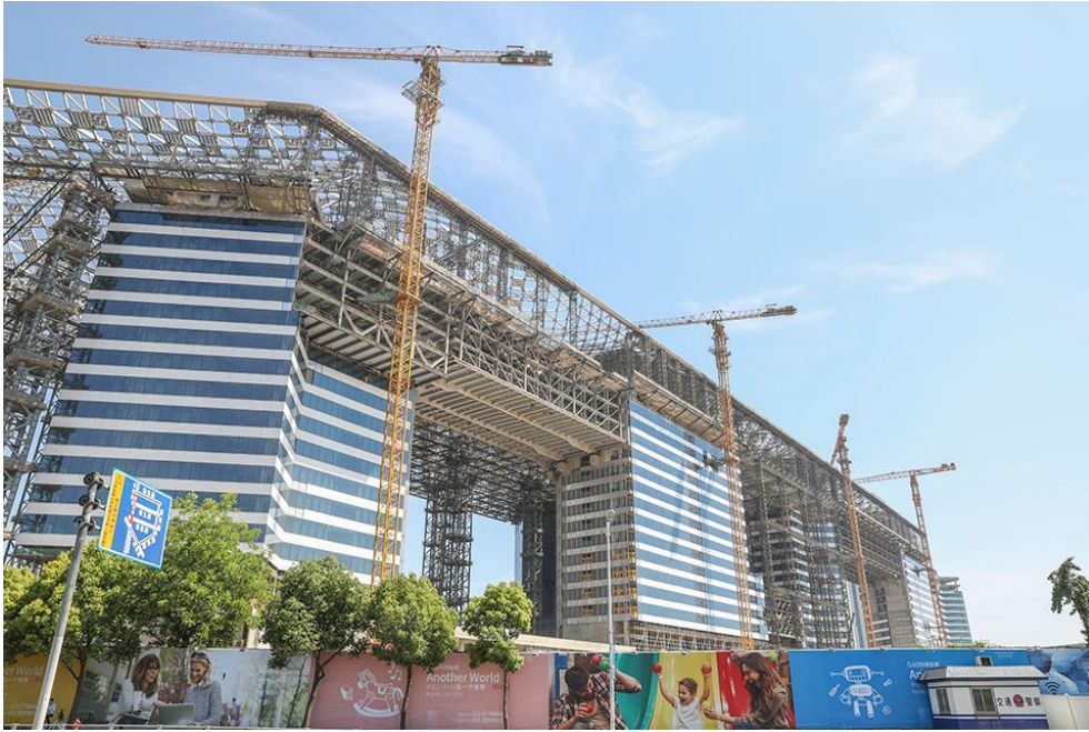
上海拉斐尔云廊项目 4000 吨 2018 年 10 月完成 主要规格：锥管
