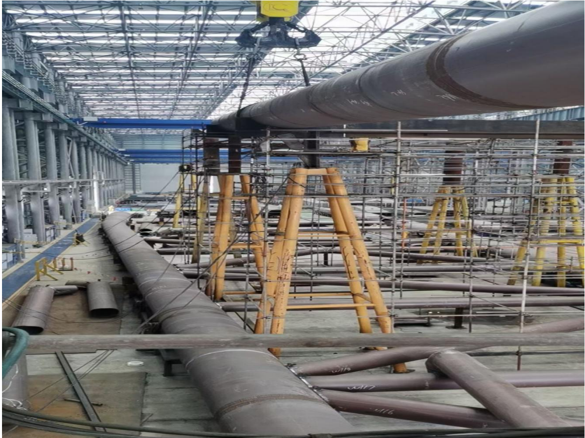
JSD6000 铺管船托管架项目 1000 吨 2021 年 4 月完成 主要规格: 1600*100/50/30/20 700*20/30
